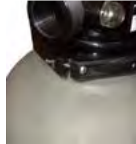
Abb. Spannring montiert mit Ventil auf Filterhals.
